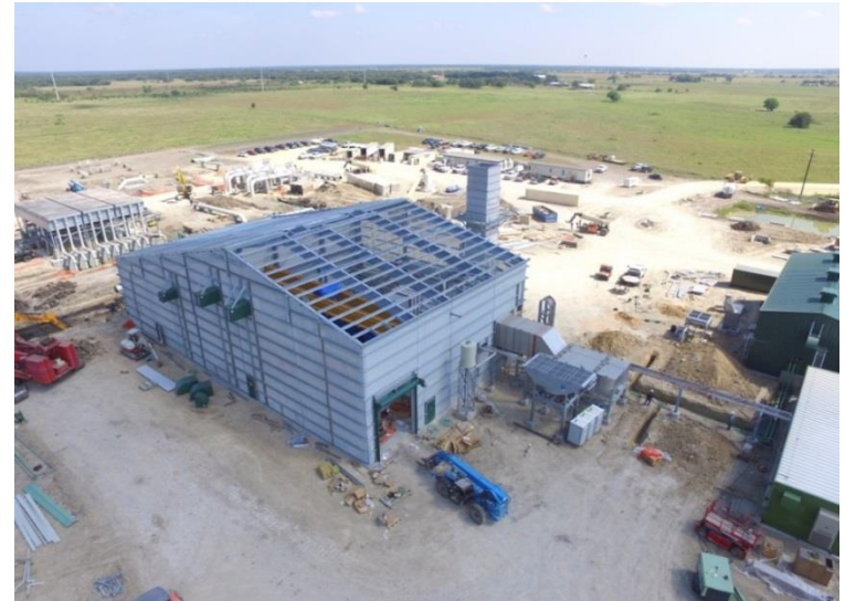
Lone Star – Sta. 3A Construction
